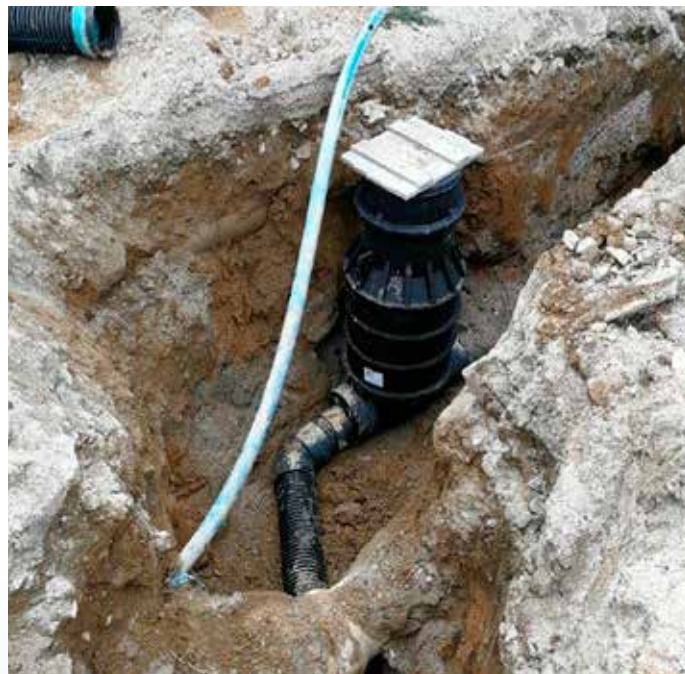
Izkopi za kanalizacijo
